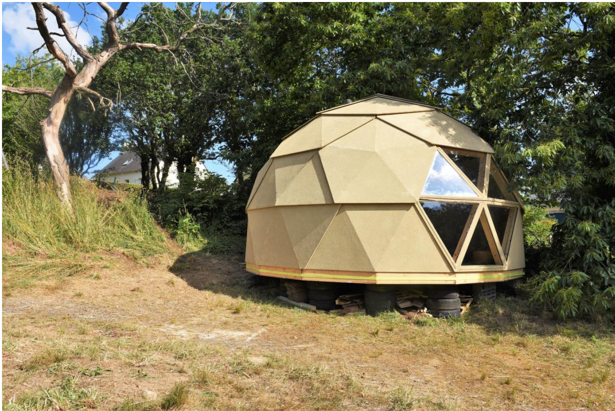
Dôme sur le terrain à Commana en juillet 2023 (source Cerema)
