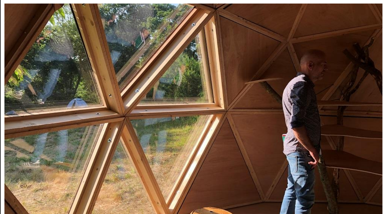
Partie vitrée (double vitrage). Source: Margaux Olivré
